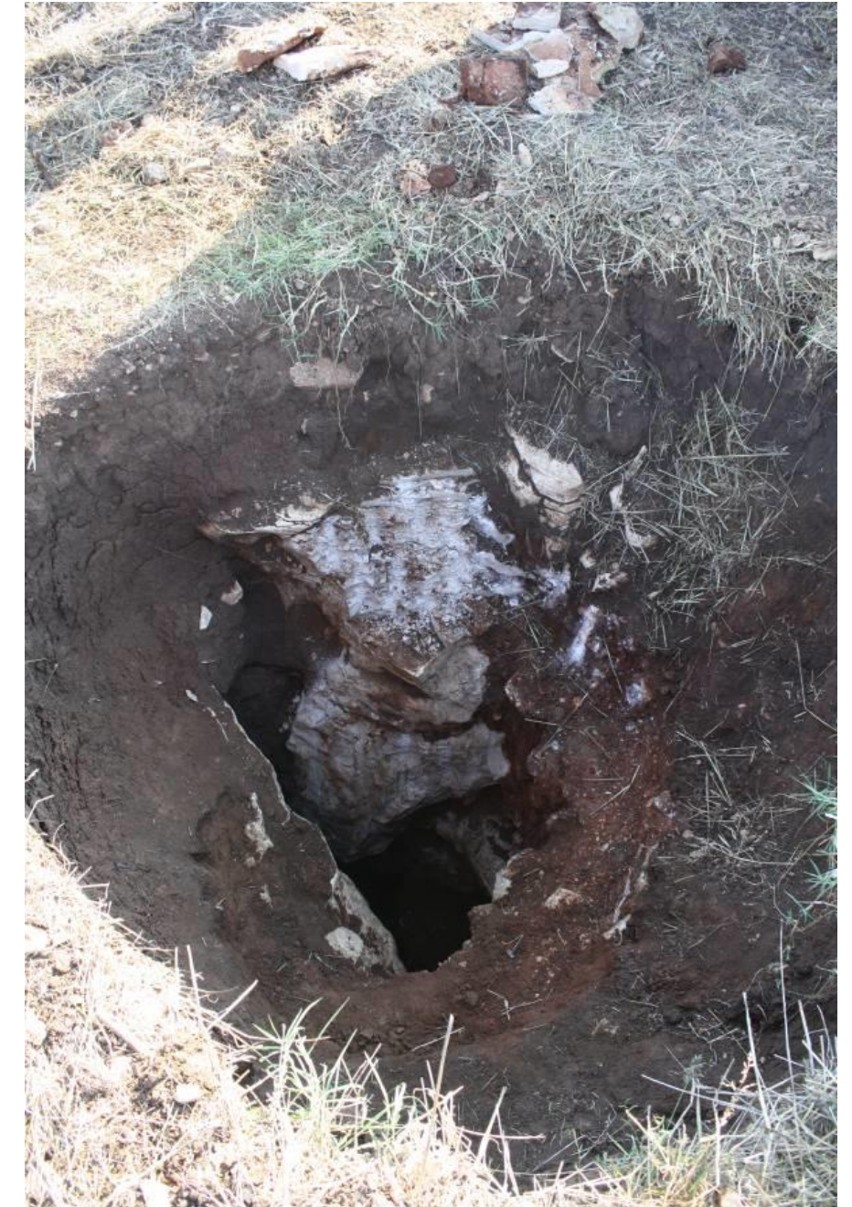
Fig.4.1.28 L'imbocco di una cavità apertasi nel 2010 per sprofondamento dello strato di suolo. Ripresa effettuata prima della sistemazione di sicurezza.
