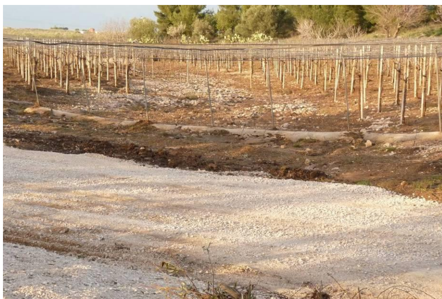
Fig. 4.2.18 e Fig. 4.2.19 Il ripristino del manto stradale (sopra) distrutto dalla piena del marzo 2011 (c.da Pozzo Sorgente); in secondo piano, sotto il vigneto, depositi di pietrame trasportato dall'acqua sottraendolo ai muretti a secco e al suolo. In basso, l'effetto della piena nell'erosione del suolo; si nota l'assenza del muretto a secco in corrispondenza della linea di impluvio.
