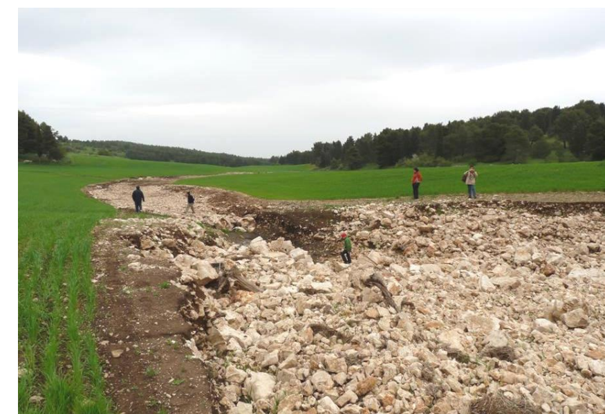
Fig. 4.1.10 Veduta di una lama della Murgia ruvese: la Lama Ferratella, in un tratto ampio circa 150 m. In primo piano gli effetti della piena su un riempimento artificiale di pietrame, nel 2009.
