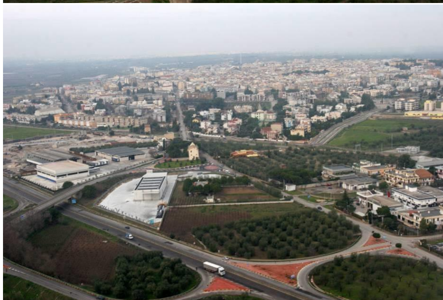
Fig. 6.1.10 Insedimenti produttivi realizzati mediante Sportello Unico delle Attività Produttive
