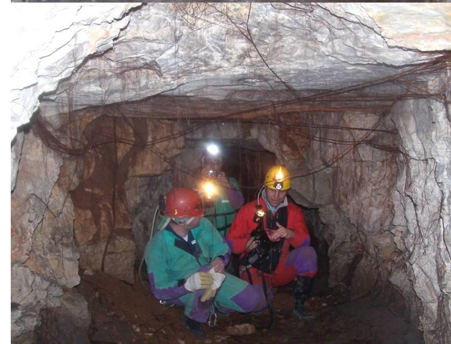
Fig. 4.1.31 Aspetti dell'interno della galleria Pantano-Mondragone. In alto è evidente lo stato della roccia, stratificata e compatta; in basso si notino le radici e la terra rossa, indizio della posizione superficiale.
